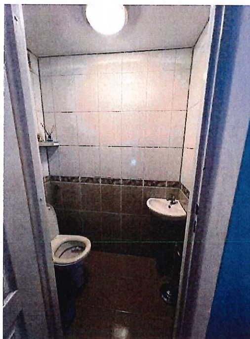
WC (I piętro)
